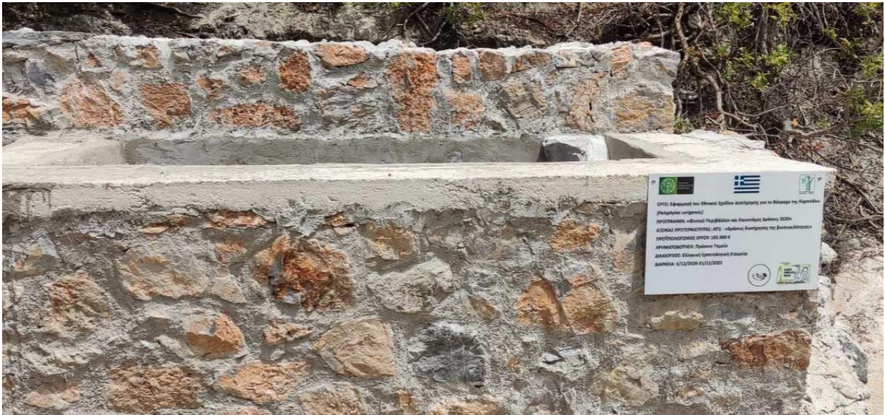
Εικόνα 9. Νέο ληνίο-δεξαμενή στο Αργώνι.
