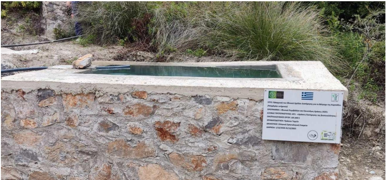
Εικόνα 8. Νέο λιμνίο-δεξαμενή στην Αχαμάντια.
