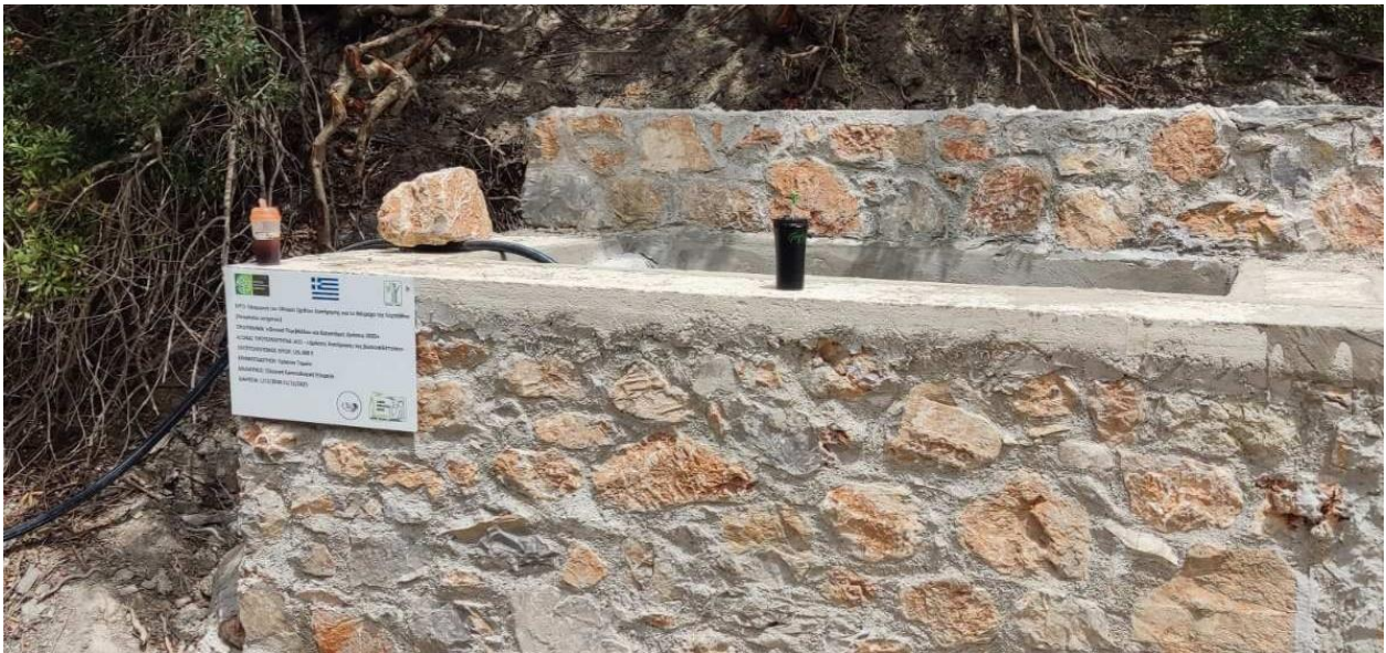
Εικόνα 10. Νέο ληνίο-δεξαμενή στο Αργώνι.
