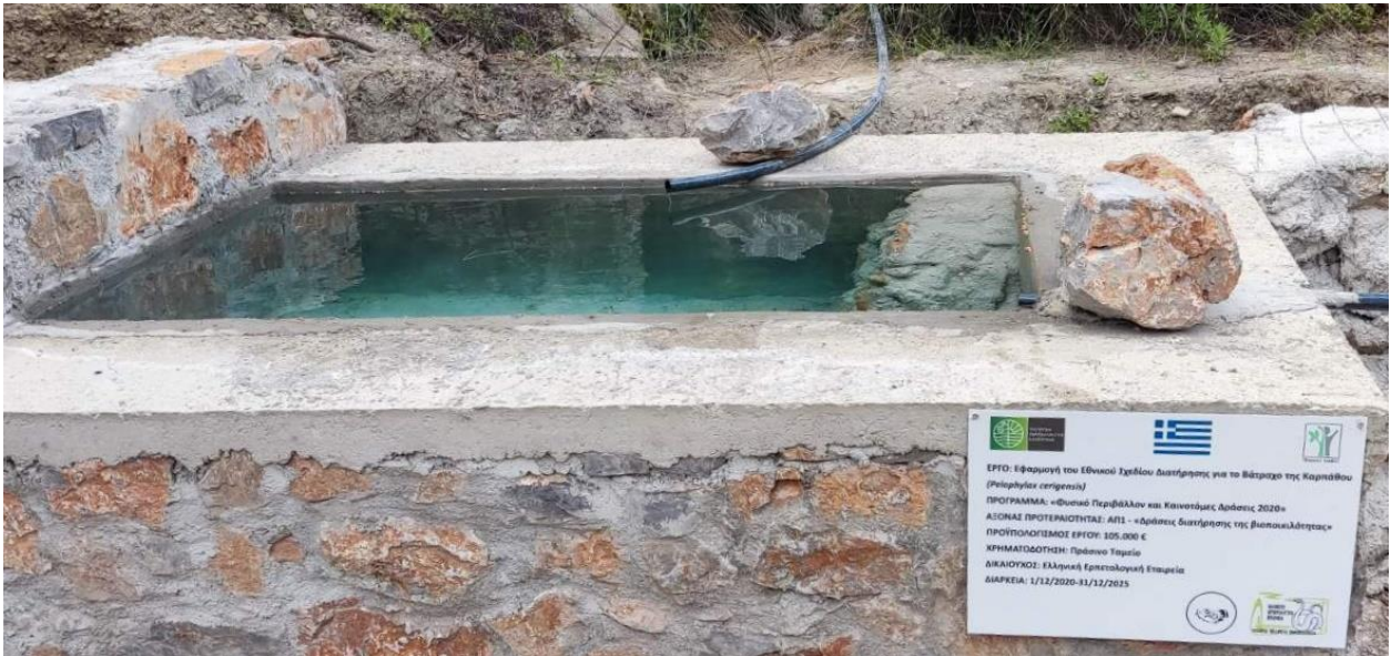
Εικόνα 7. Νέο λιμνίο-δεξαμενή στην Αχαμάντια.
