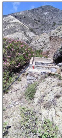
Εικόνα 12. Άποψη υφιστάμενης στέρνας βυρσοδεψίου στην οποία καταλήγει η υπερχειλίση από την στέρνα που έχει κατασκευαστεί στην Πηγή Παναγίας Ελεημονήτριας. (Παραδοτέο I.A.CO Environmental and Water Consultants Ltd).
